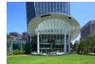
屋上庭園「オーバル広場」
